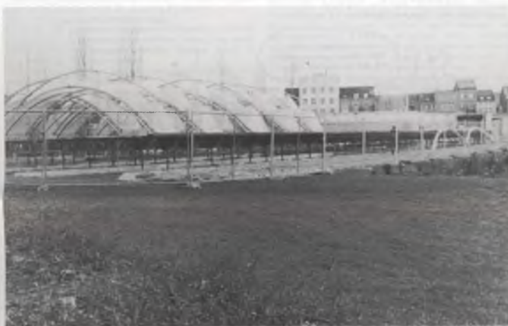
Dit futuristisch bouwsel tussen de gebouwen B en M is nu een IBM-toonstelling.
